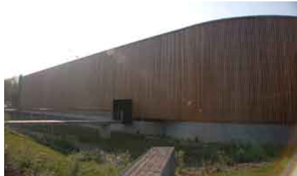
Parking silo en bordure du quartier Wolf Wagner
