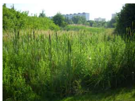
Bassin de rétention dans le Parc des Collines à Mulhouse. La végétation abondante rend le bassin inaccessible.
