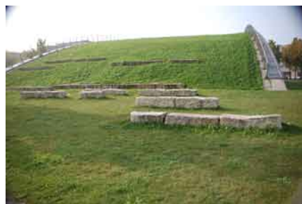
Toiture enherbée de la salle sportive à Freiburg (D), quartier Riesenfeld. La volonté de créer un équipement supplémentaire en gardant la même surface d'espace vert a pour résultat cette «butte enherbée» accessible.
