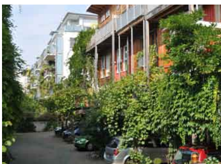
Végétation luxuriante accrochée aux structures des balcons à Freiburg (D) quartier Vauban. Cette végétation entre dans la composition d'une trame verte et apporte une fraîcheur naturelle en période estivale.
