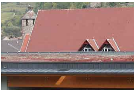
Toiture végétalisée du COSEC à Kaysersberg. Elle nécessite un entretien annuel consistant à éliminer les pousses végétales non désirées.
