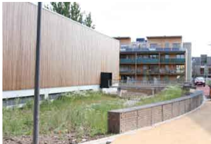
Rivière sèche pouvant récupérer les eaux pluviales dans le quartier Wolf Wagner Mulhouse.
