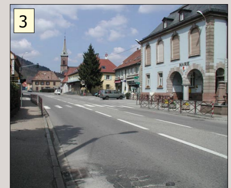
3 Le carrefour de la Mairie n'est pas assez marqué
