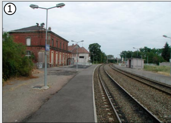
① Le bâtiment voyageur n'est plus utilisé. Seul le logement à l'étage est occupé.
