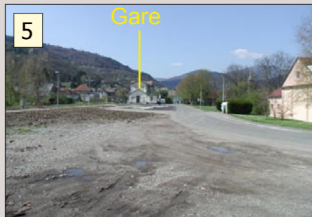
5 La gare est à l'écart du reste de la commune
