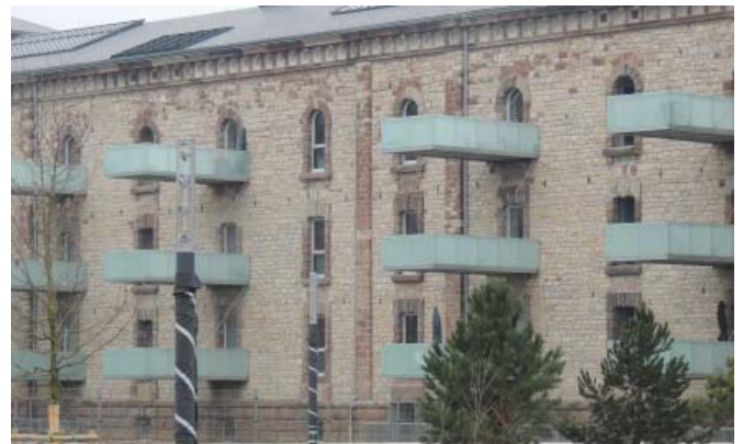
La Caserne Lefebvre, à Mulhouse : les bailleurs sociaux sont en pointe dans la lutte pour la qualité thermique des bâtiments
