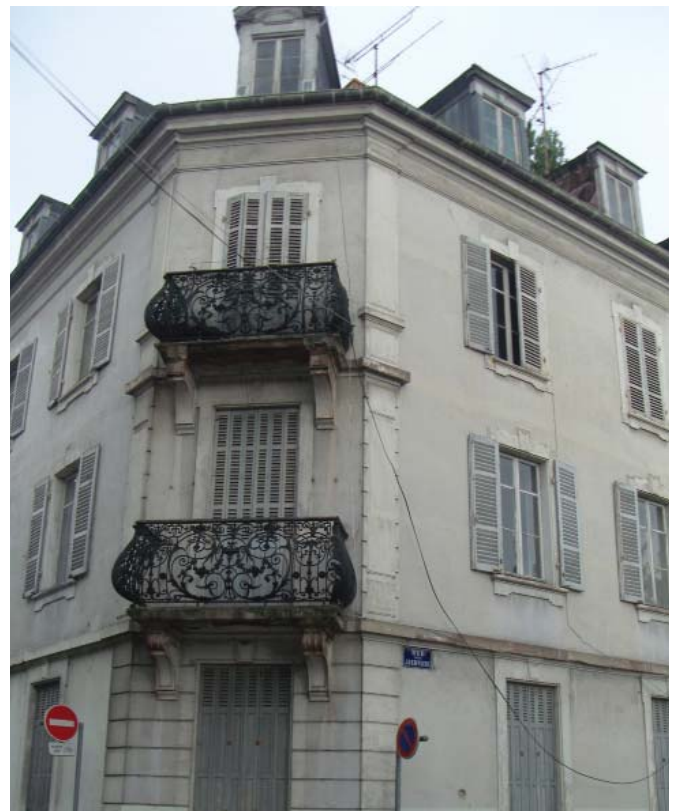
Exemple d'habitat ancien dégradé rue des Jardiniers dans le quartier Fonderie/Porte du Miroir.
