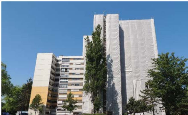
Chantier de la rénovation thermique de la copropriété Delacroix, aux Coteaux
