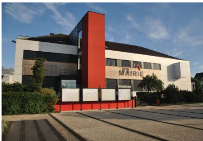
Transition énergétique et rénovation thermique sont des sujets qui nous concernent tous. La Mairie de Staffelfelden a ainsi été rénovée en 2011. C'est aujourd'hui un bâtiment répondant aux normes BBC.
