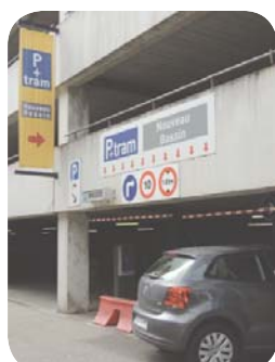
P+R Nouveau Bassin, à Mulhouse
