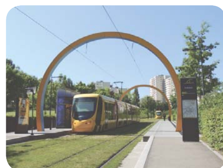
Ligne 2 du tramway, Coteaux, Mulhouse
