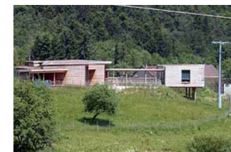
Un bâtiment bien intégré dans le site
