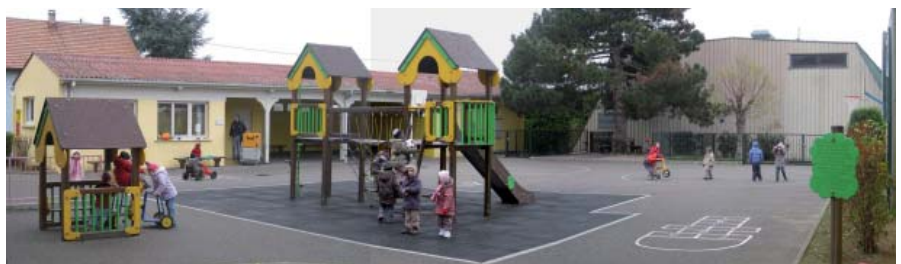
Berrwiller : vue générale du périscolaire et de la salle des sports.
