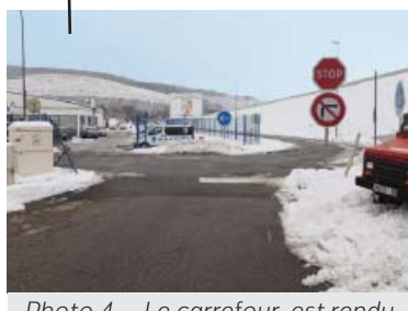
Photo 4 - Le carrefour est rendu dangereux par un manque de lisibilité des sens de circulation
