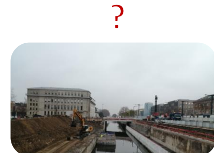
Mulhouse : Réouverture du canal (en cours)
