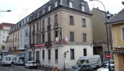
immeuble rue Thénard AVANT
