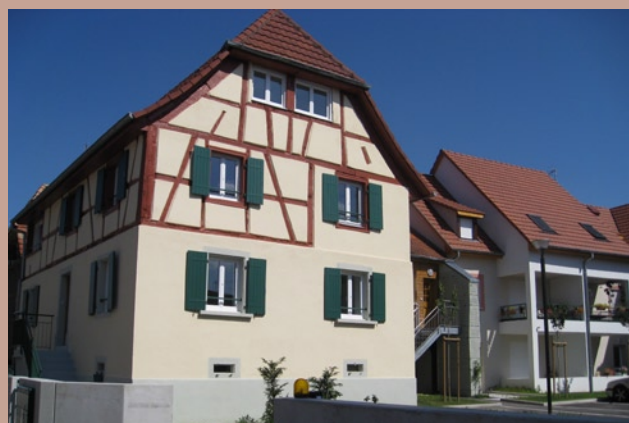
Réhabilitation d'une maison alsacienne et construction neuve. Programme de 15 logements sociaux, Reiningue
