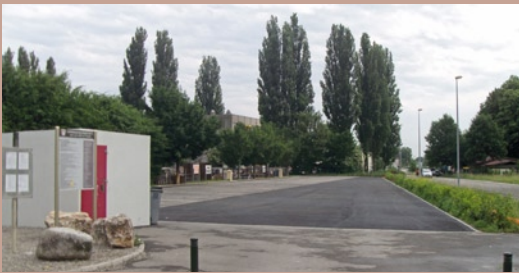
Aire d'accueil de Brunstatt
