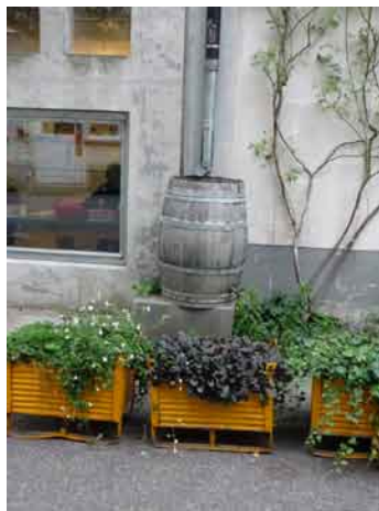
Basel - Gundeldinger Feld : système de récupération des eaux pluviales réutilisées pour l'arrosage
