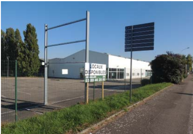
Bâtiment commercial vide depuis peu rue de Fribourg. Entreprise : CEDEO
