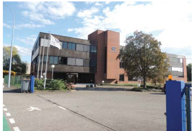
Un bâtiment atypique dans le contexte industriel, sa forme architecturale dénote dans la morphologie urbaine environnante. Entreprise : Claudius Peters Technologies
