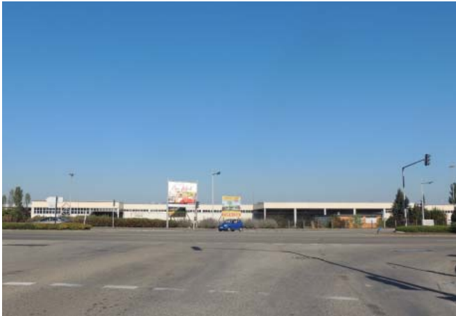
Bâtiment libre avec deux freins à son réemploi : - une configuration particulière - une situation dans le périmètre d'autorisation sous conditions, limitant l'activité qui pourrait s'y développer Entreprise : Tresch group
