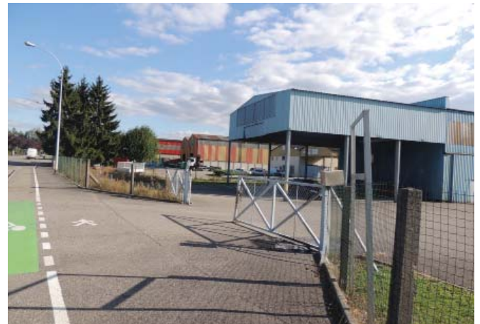
Bâtiment vide dans le périmètre d'interdiction, difficilement réutilisable Entreprise : SOCLEMI
