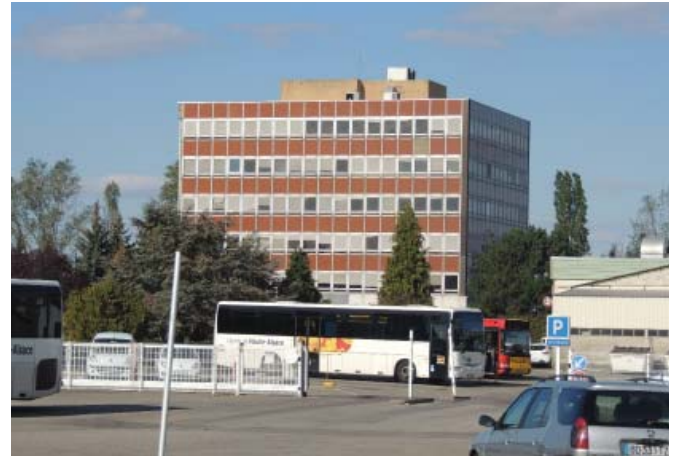
Le bâtiment de bureaux est vide depuis très longtemps. Il est difficilement vendable car totalement «amianté». Entreprise : DMC
