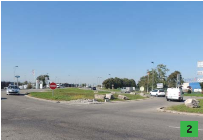
Autre point noir, cette intersection entre carrefour et giratoire Lieu : croisement entre avenue de Fribourg et avenue de Hollande
