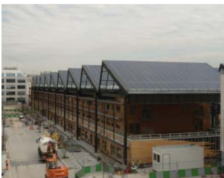
La reconversion de la halle Pajol (Paris) a permis de produire de l'énergie renouvelable par des panneaux photovoltaïques Source : Halle Pajol © G. Noble
