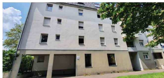
Location réalisée rue des pins à Mulhouse (Franklin)
